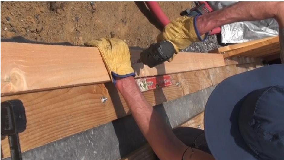
N.B. Les choix constructifs influencent la manière dont on réalise ces lisses basses. Dans le cadre de ce chantier, le fait d'avoir placé des blocs de béton cellulaire sur le haut des fondations, côté extérieur, a obligé le maître d'ouvrage à placer une lisse plus large côté extérieur. De même, le souci d'éviter que la paille ne se retrouve en contact avec les boulons d'ancrage (ponts thermiques, remontées capillaires), rend nécessaire la pose d'une deuxième lisse basse au-dessus de la première.
