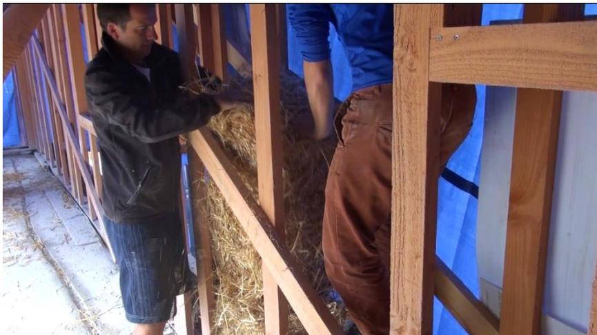
Au préalable, nous aurons contrôlé leur humidité, leur masse (entre 14,5 et 15,5 kg) et leurs dimensions (typiquement : 36 x 46 x 80 cm). La conductivité thermique ( $\lambda$ ) de la paille dépend de la densité (pressage lors de la mise en ballot) et est typiquement entre 0.04 et 0.08 W/m.K.
