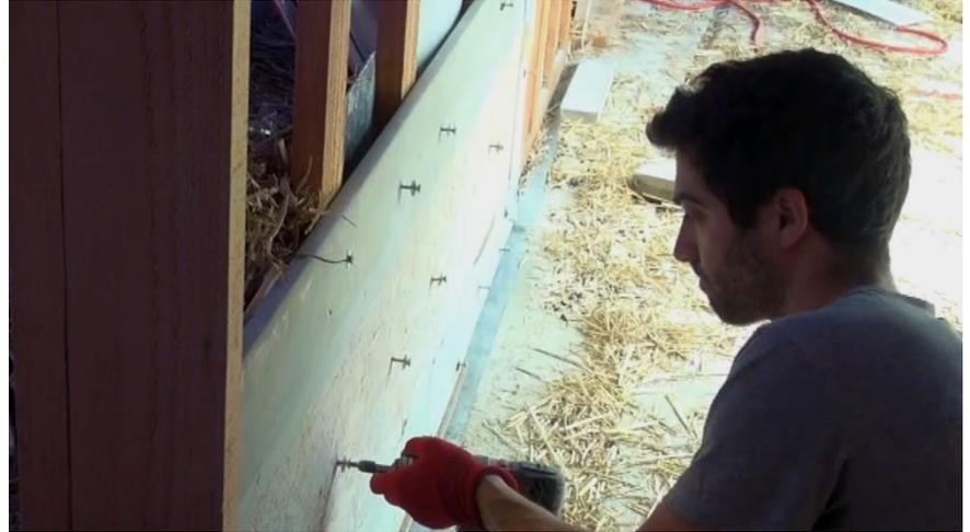
Avant de visser ces panneaux, il s'agit d'introduire entre le ballot de paille et les clous des feuilles plastiques rigides. Celles-ci faciliteront grandement le coulage du mortier et permettront de le tasser.
