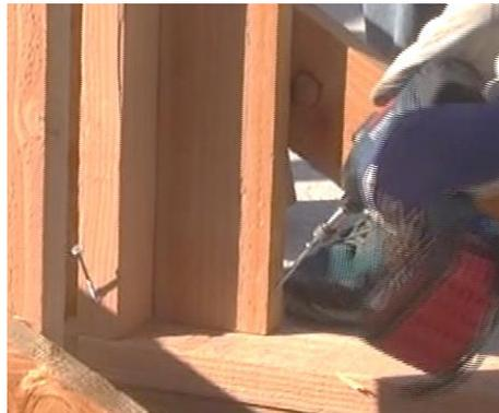
De part et d'autre d'une baie vitrée, nous construisons des piliers plus rigides constitués de 8 poteaux montés 2 à 2 pour en faire les coins. Ses dimensions permettront d'insérer un ballot de paille en vertical.
