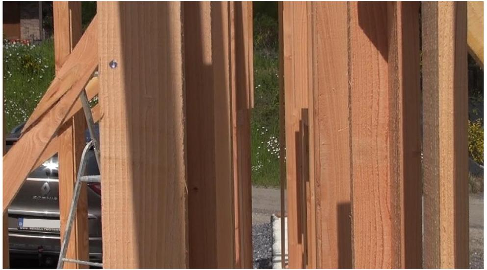
Après avoir bien établi les mesures de hauteur (la lisse basse n'est pas toujours totalement plane) et découpé les poteaux, on les vissera en biais pour assurer à la fois une aisance de manipulation et une meilleure résistance à la traction.
