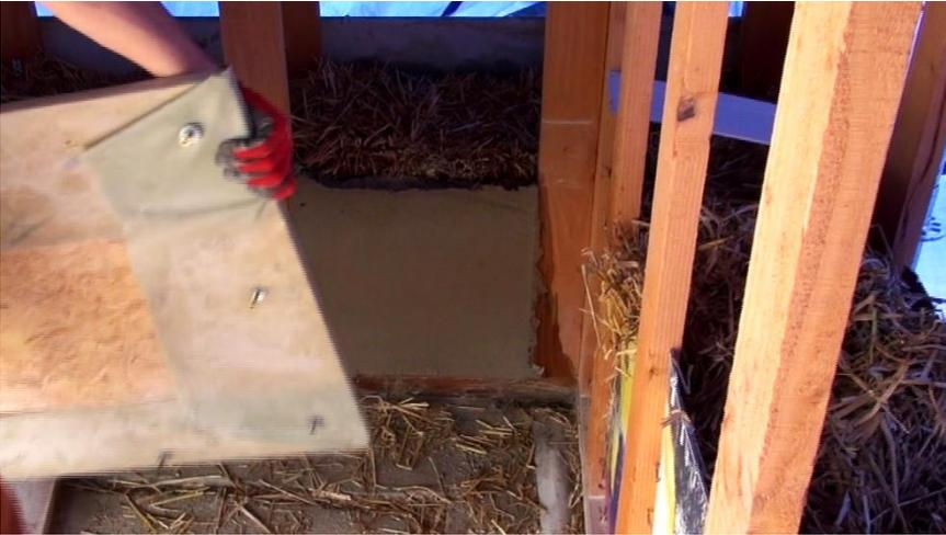
Il est à noter qu'il faut bien souvent, après le décoffrage, boucher les anfractuosités qui sont assez fréquentes le long des poteaux. De plus, la planéité des panneaux n'étant pas toujours parfaite, il est nécessaire la plupart du temps, d'égaliser le mortier en retirant une partie.
