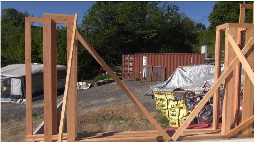
Lorsque les poteaux et les piliers sont réalisés et vissés à la lisse basse, nous pouvons placer la lisse haute. C'est le moment de s'assurer des aplombs des poteaux, piliers et en particulier des coins du bâtiment. Les lisses hautes sont coupées à 45° là où elles doivent être assemblées entre elles.
