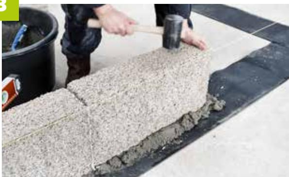
Appliquez un lit de mortier uniformément étalé et d'une épaisseur d'1 à 2 cm.
