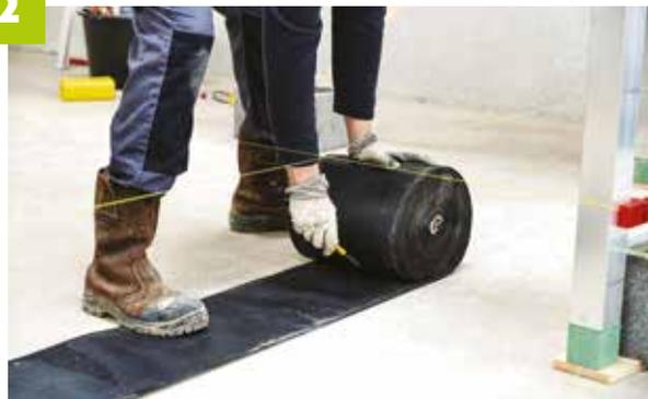
Les blocs de chanvre IsoHemp doivent être protégés des remontées capillaires. Appliquez une bande d'étanchéité (type DIBA) à remonter de 2cm le long du bloc de chanvre.
