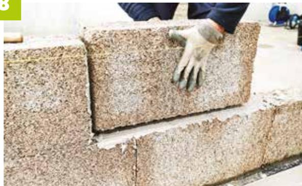
Posez le bloc sur la colle pour une maçonnerie en joints minces de 3mm après avoir pris soin d'encoller les surfaces du bloc (double encollage).
