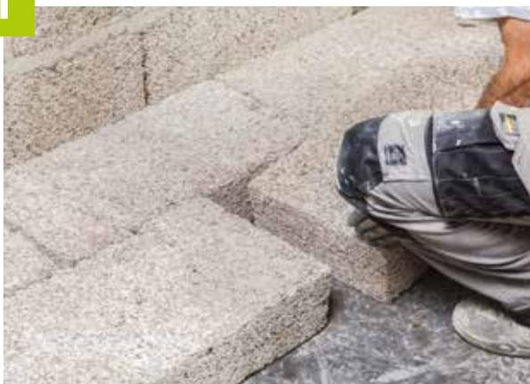
Vérifiez l'étanchéité de la fondation avant de poser le bloc sur stabilisé ou dalle de béton.
