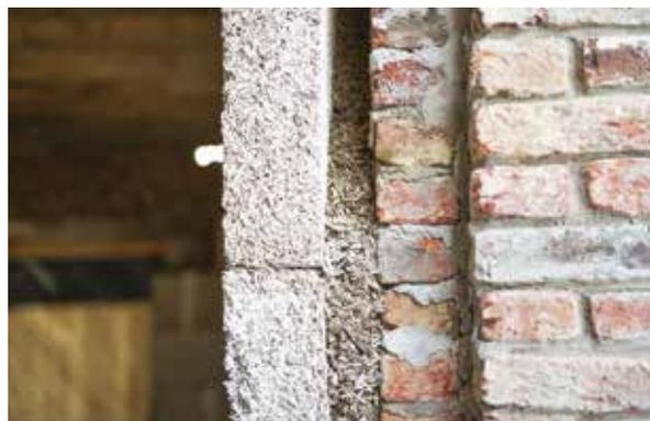
Ne laissez aucun vide d'air afin d'éviter tout problème d'humidité possible aux interfaces des différents matériaux.
