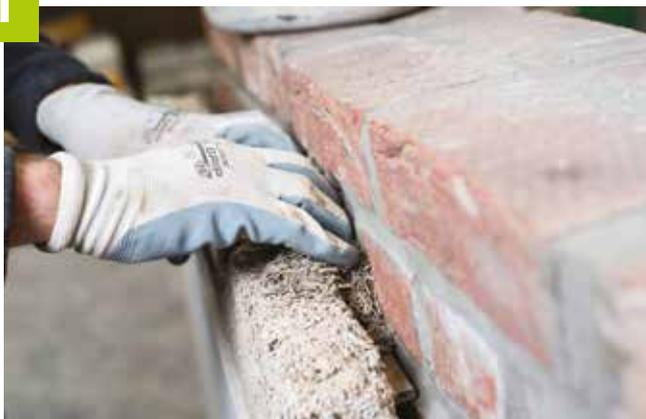
Remplissez manuellement au fur et à mesure l'espace entre le mur existant et les blocs.
