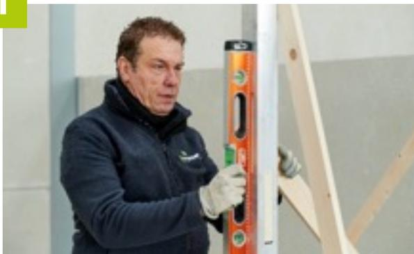
Recherchez le point le plus élevé de la dalle à l'aide d'un laser, d'un niveau à eau ou d'un niveau.
