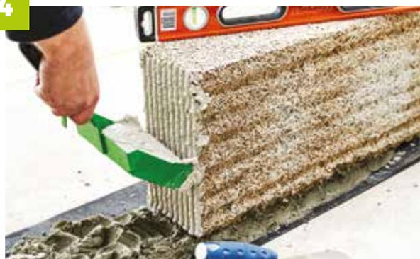
Encollez le joint vertical et appliquez le bloc suivant. Ajustez au maillet si nécessaire pour obtenir un joint mince vertical de 3 mm.
