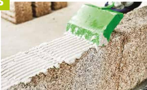
Appliquez la colle à l'aide d'une truelle crantée sur toute la surface horizontale du bloc déjà posé pour assurer l'étanchéité du joint.
