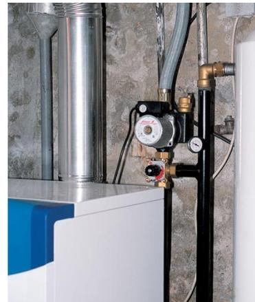
3. Attention, sur les chaudières compactes et plus récentes, le circulateur peut se situer à l'intérieur de l'enveloppe et ne pas être visible. Le démontage de la coque n'est en général pas indispensable pour évaluer le fonctionnement du circulateur.
