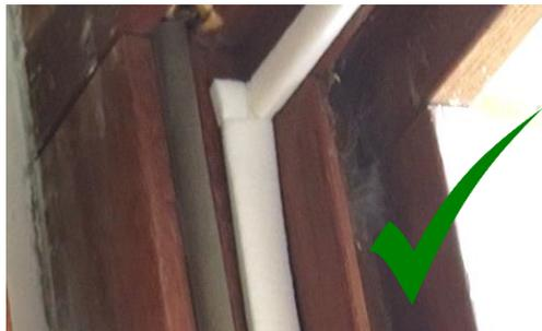
9. Vérifiez que la porte ou la fenêtre se ferme encore facilement. Une légère résistance n'est pas problématique. Mais si rabattre la clinche pose un problème, c'est l'indication que le joint utilisé est trop gros ou qu'il n'a pas été bien placé.
