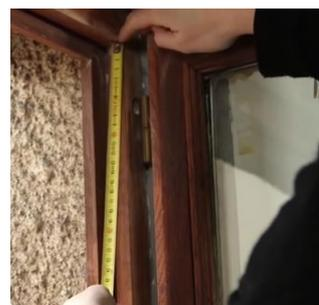
3. Reportez la mesure sur la bande de joint (ajoutez quelques millimètres quitte à recouper lors du positionnement sur la menuiserie).
