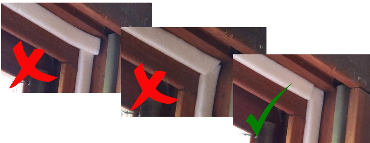
8. La plupart du temps, les zones de frappes sur les montants verticaux du côté des charnières ne sont pas sur la même face que ceux des autres montants. Il faut donc veiller à placer le joint de telle manière qu'il soit bien en compression et ne risque pas d'être arraché lorsqu'on ferme la porte ou la fenêtre.
