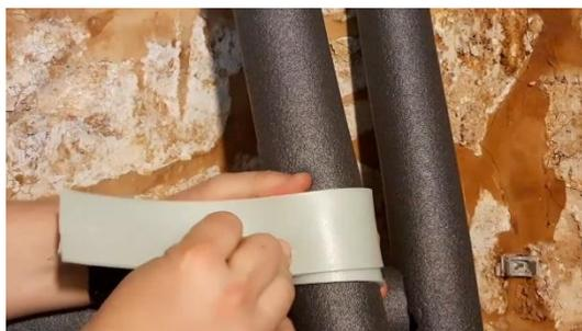
8. Progressez de proche en proche en répétant les opérations 4 à 6 jusqu'à couvrir tous les tuyaux de ce diamètre. Veillez à utiliser les chutes le mieux possible.
