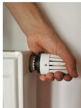
Le thermostat d'ambiance devrait se situer dans la pièce la plus occupée, sur un mur intérieur non exposé au soleil, et être réglé sur 20°C pour le jour et sur 17°C pour les heures de nuit.
